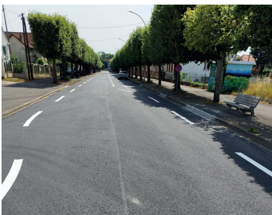
■ 30 juillet - réhabilitation de l'avenue de la République, un plateau a aussi été créé au droit de l'école de la Gare.
