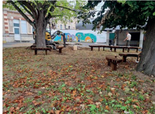
■ Renaturation des cours des écoles Cuiry et Marcel Boulmier.
