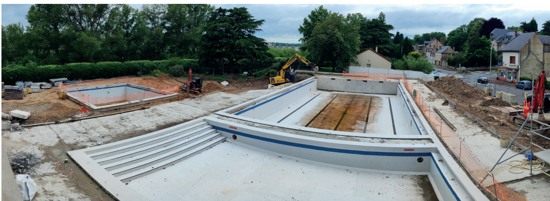
■ 20 juin - fin des opérations de démolition au stade nautique (CDCG)
