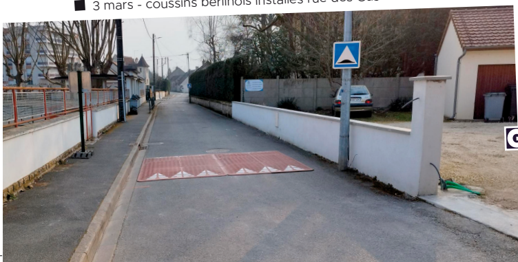
■ 3 mars - coussins berlinois installés rue des Gascons.
