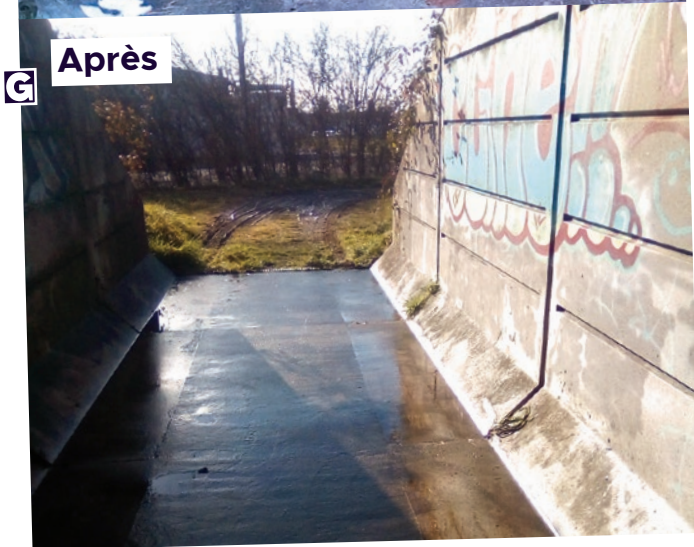
■ Nettoyage du passage annexe au chemin de la Saulaie sous la D952.
