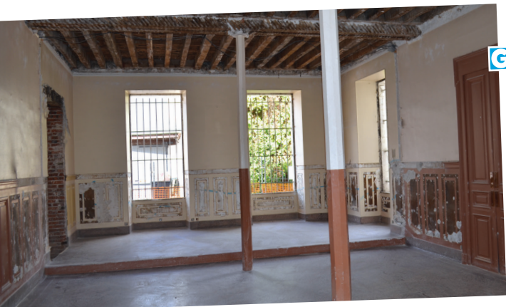
mai : début des travaux de réhabilitation
