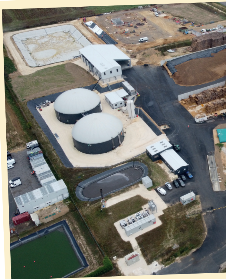
■ Site des 3 Dômes à Arrabloy la méthanisation en service et le déconditionneur en construction.
